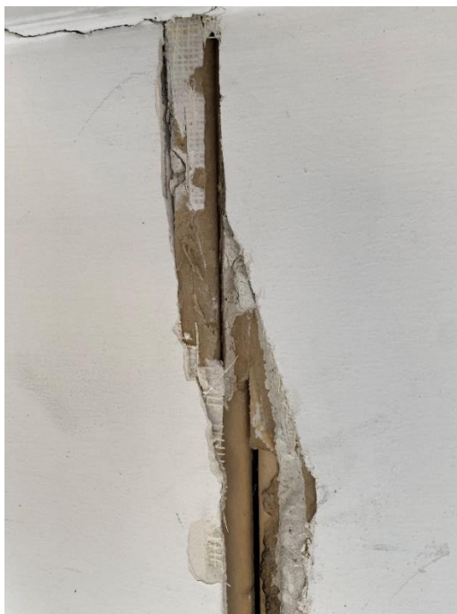
Gipskartonplatten zweilagig an den Decken, sowie das Streckmetall an den Wänden aus Der Bauphase von 1982
