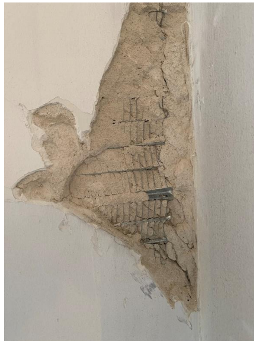
Gipskartonplatten zweilagig an den Decken, sowie das Streckmetall an den Wänden aus Der Bauphase von 1982
